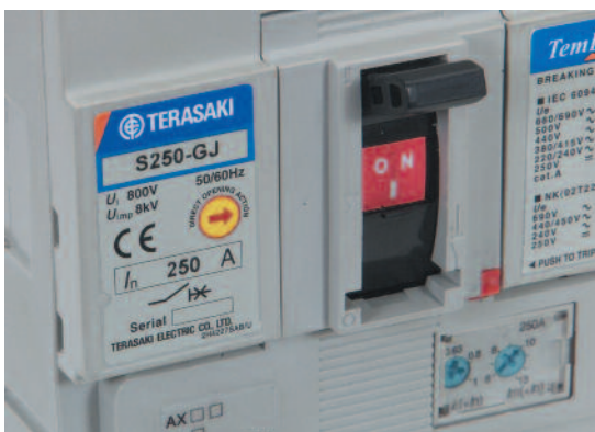
MCCB con térmico y magnético ajustables
