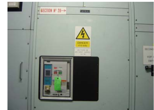
Después: Retrofit ACB, relé de protección con LCD
