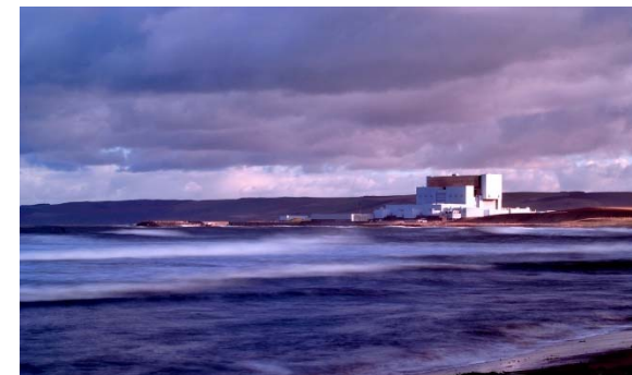
Central eléctrica Torness
