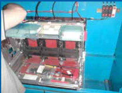
Ingénieur du Direct Response en installant un ACB de Rétrofit
