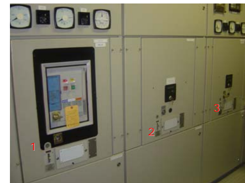
1. ACB1: después de la sustitución 2. ACB 2: antes de la sustitución 3. Bus: Acoplador - antes de la sustitución
